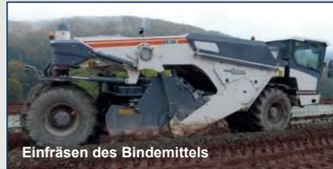
Aufbereitung des Abtrags Vor Bindemittelauftrag
