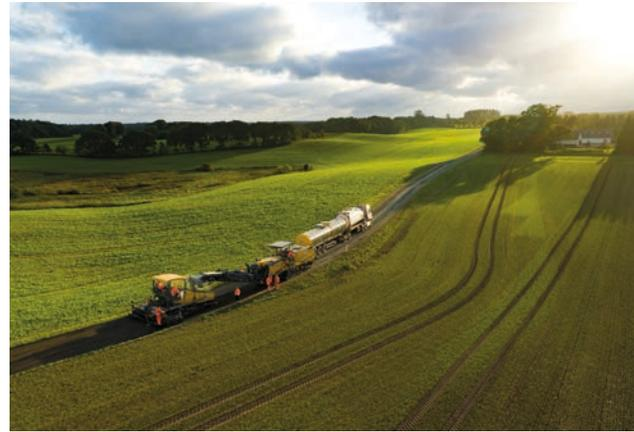
*Granuliert und gemischt in einem Arbeitsgang übergibt der W380CRi das BSM Mischgut direkt in den Bunker des Vögele Fertigers.*
