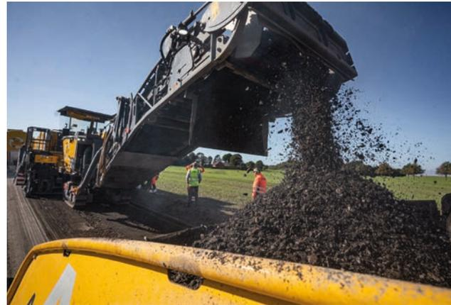
*BSM ist seit Jahrzehnten weltweit erprobt und zeichnet sich durch Flexibilität und Dauerhaftigkeit aus. 10 cm Schichtdicke sind die Mindestanforderung an eine nachhaltige BSM-Tragschicht, in Silkeborg baute der SUPER 2100-3i das Material 12 cm hoch ein.*
