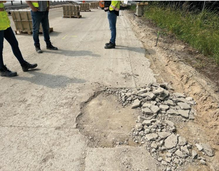
Abb. 2: Typische Fehlstellen am hochliegenden Rand.
